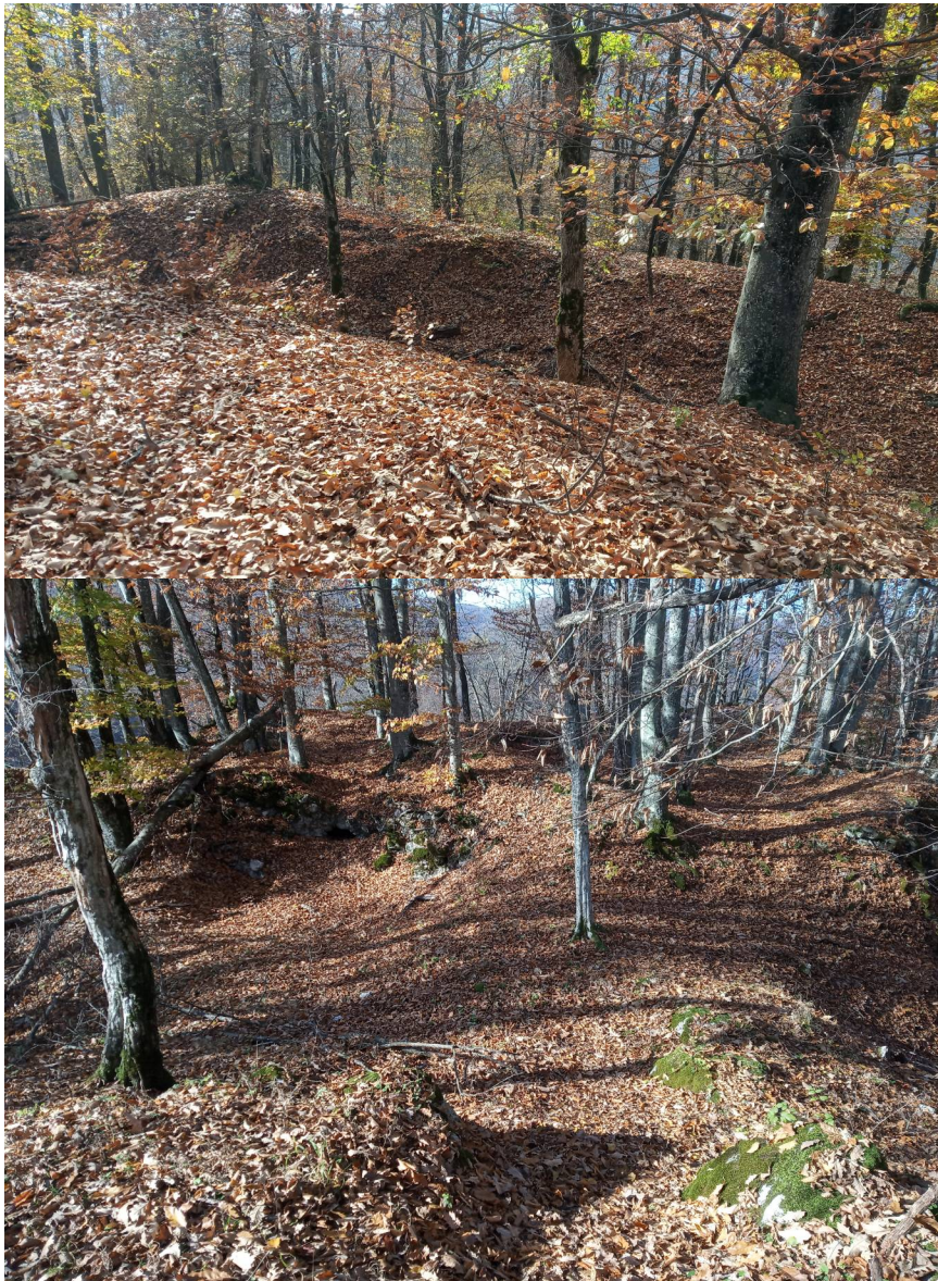
Obr. 3: Priekopa a opevnenia I. hradu (hore) a pohľad na premostenie a pivnicu v polohe III. hradu v Rybníku nad Turcom (dole).
